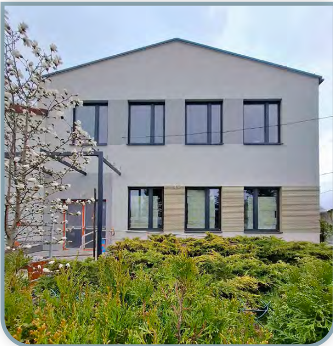
↓ Remont Szkoły Podstawowej w Wielkiej Wsi
