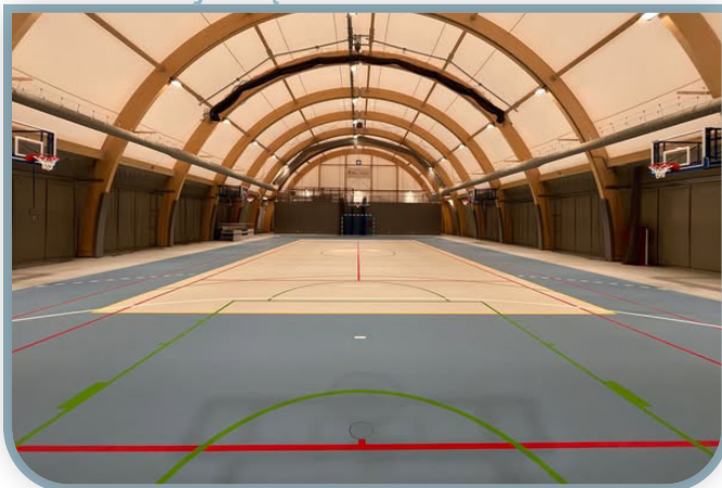
↓ Budowa boiska wielofunkcyjnego przy Szkole Podstawowej w Będkowicach
