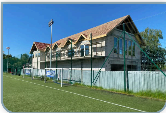
↓ Budowa Centrum Aktywności Społecznej w Modliczce
