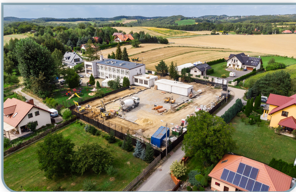
↑ Budowa nowego boiska wielofunkcyjnego z zadaszeniem przy Szkole Podstawowej w Będkowicach
