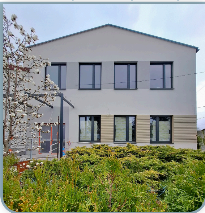
↓ Remont Szkoły Podstawowej w Wielkiej Wsi
