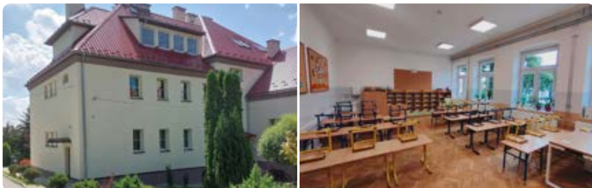
W wakacje przeprowadzono remonty i modernizację w Szkołach Podstawowych.
