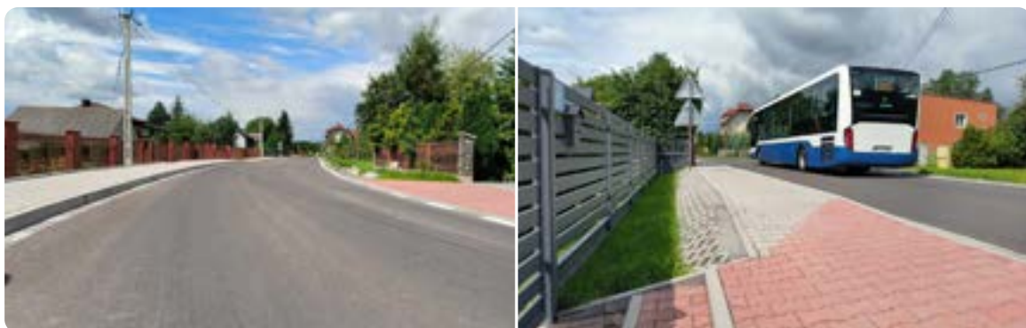
Zakończył się remont odcinka drogi powiatowej ul. Kawiory w Będkowicach. W ramach zadania powstała nowa nakładka, chodnik, umocnienia rowów, przepusty i wszelkie prace towarzyszące wraz z oznakowaniem.
